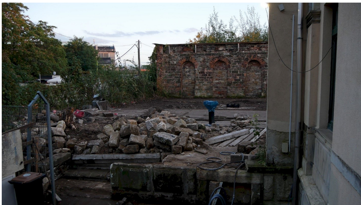
Die Brachfläche wurde beräumt und die Laubhütte errichtet. Foto: Herbert Lappe
